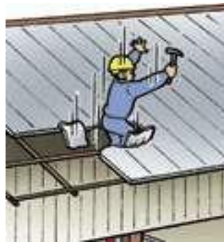
「屋根の踏み抜き・墜落」
