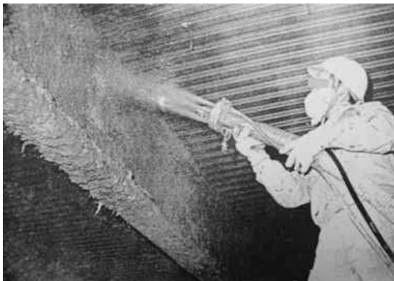
鉄骨梁への吹き付け塗装
