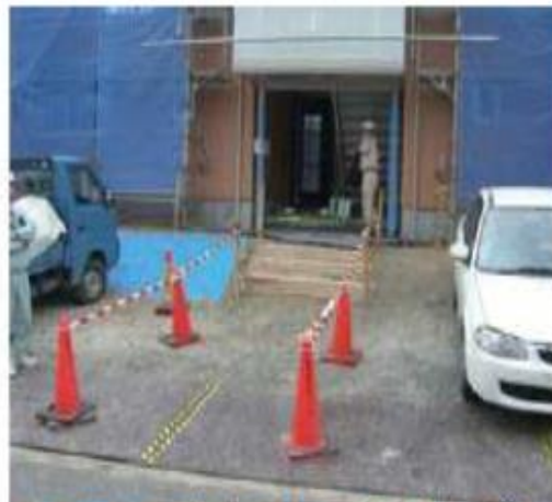
* トラテープで敷鉄板の段差も改善
